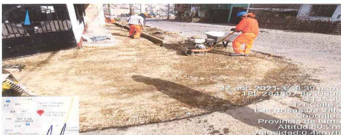
12. Trabajos de compactación a nivel de base en veredas.
